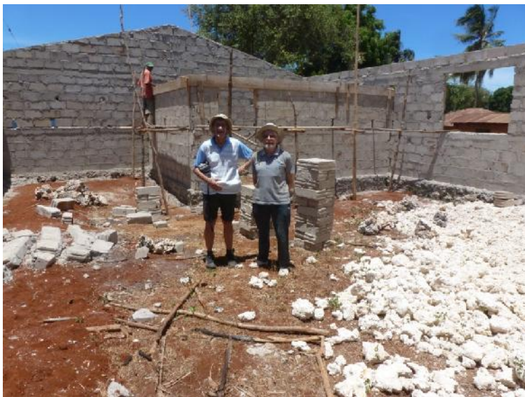
Het wetenschapslab in aanbouw, in MAKUNDUCHI
